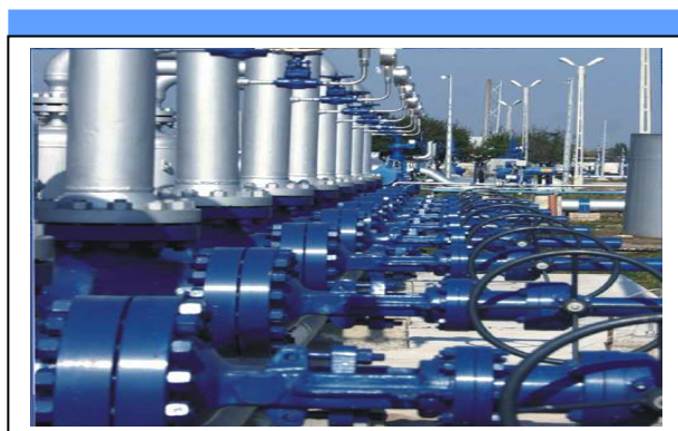
Fig. 4.11. Stație de comprimare gaze
