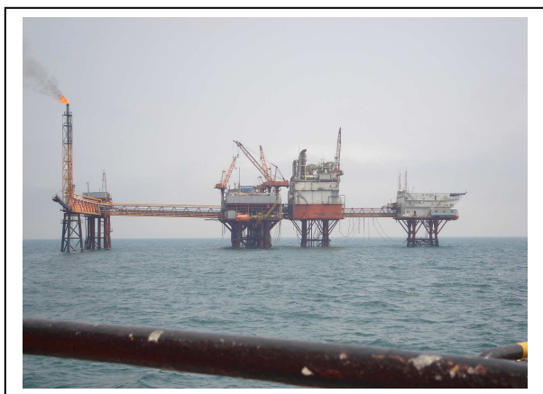
Fig. 4.1. Platforma fixă centrală de producție
